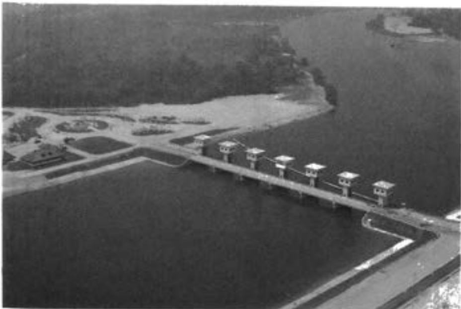
ประตูระบายน้ำบางนา จังหวัดนครราชสีมา
