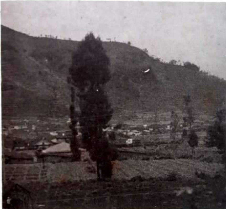
▲ การปรับระดับทำชั้นบันได เพื่อป้องกันการพังทลายของดิน
