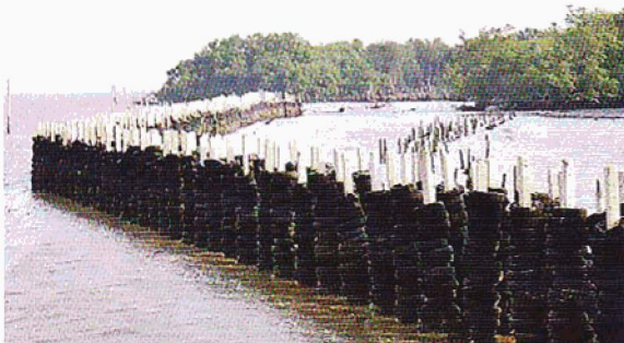
การนำยางล้อยนต์ไปทำแนวป้องกันตลิ่งหรือชายฝั่ง (ภาพจาก https://www.gotoknow.org/posts/123423 )
