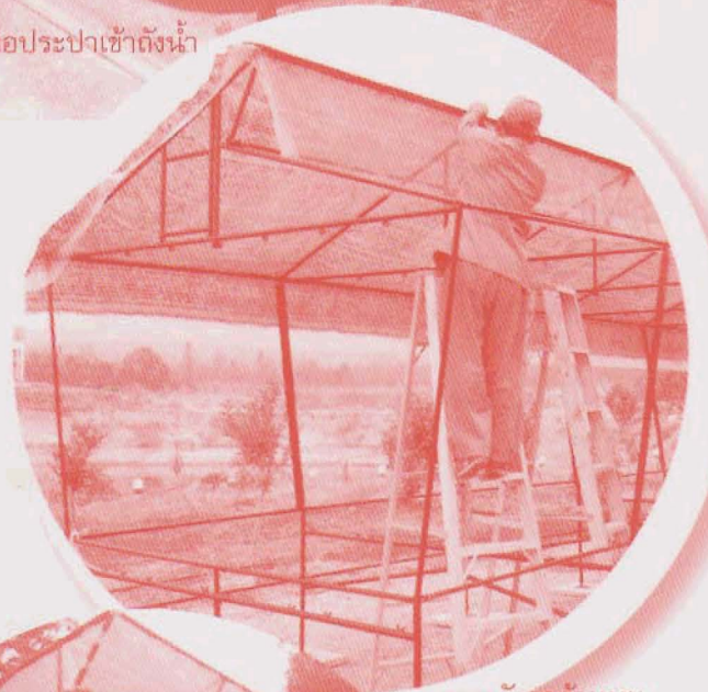
มุงหลังคาด้วยบน
