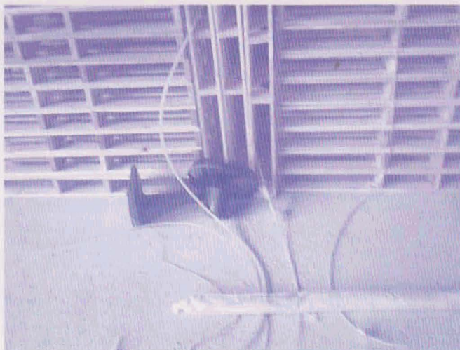
การวางที่คดลม และวางสายรัดความตึงตัวของก๊วย
