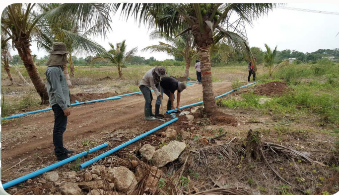
ติดตั้งและทดสอบระบบการให้น้ำพร้อมปุ๋ยเคมี จากสถาบันวิจัยเกษตรวิศวกรรม
