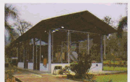
โรงไฟฟ้าสาธิตระบบสองวงจร
