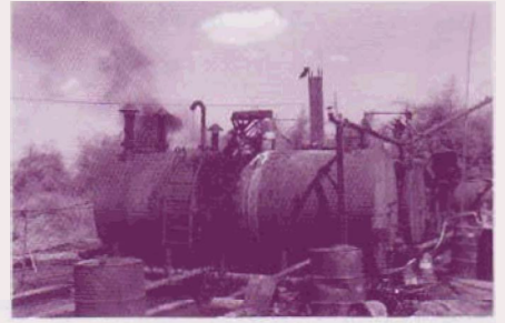
ตั้งยางมะตอย (AC 60/70) ในเตาต้มที่โรงงานผสมยางมะตอยก่อน
