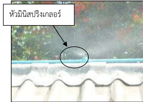
ภาพที่ 20 มินิสปริงเกอร์เพื่อลดความร้อนบนหลังคา
