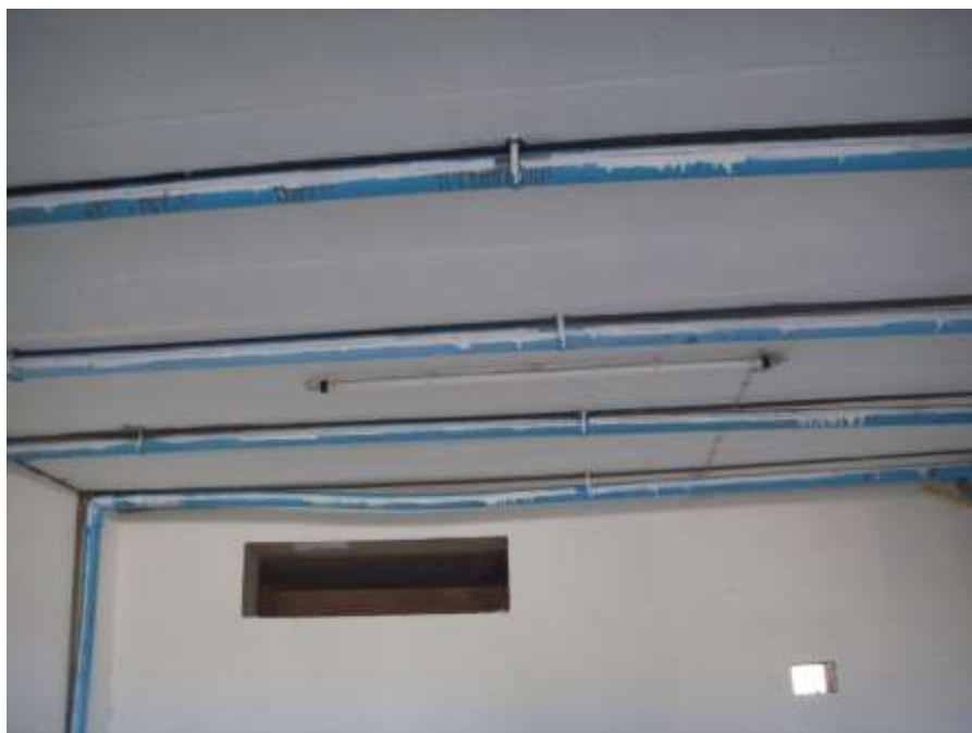
รูปแบบที่ 2 ใช้มอเตอร์ร่วมกับท่อพีวีซี ช่วยในการกระจายตัวของแก๊สซัลเฟอร์ไดออกไซด์
