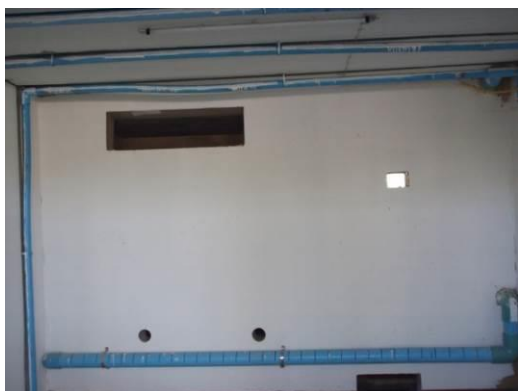
ภาพผนวกที่ 1 โรงรมแบบที่ 2 ใช้ท่อและปั้ม ช่วยในการกระจายตัวของแก๊สซิลเฟอร์ไดออกไซด์ 2 โรง
