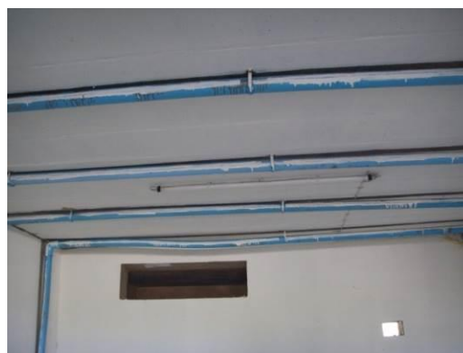
ภาพผนวกที่ 1 โรงรมแบบที่ 2 ใช้ท่อและปั้ม ช่วยในการกระจายตัวของแก๊สซิลเฟอร์ไดออกไซด์ 2 โรง
