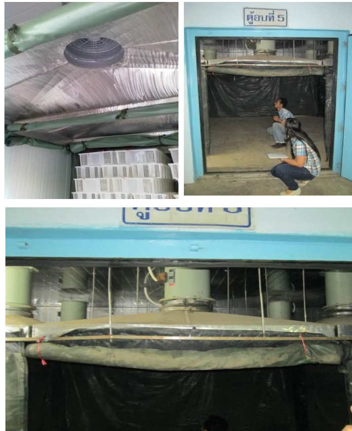
ภาพผนวกที่ 4 โรงรมแบบที่ 5 ระบบบังคับอากาศแนวตั้ง
