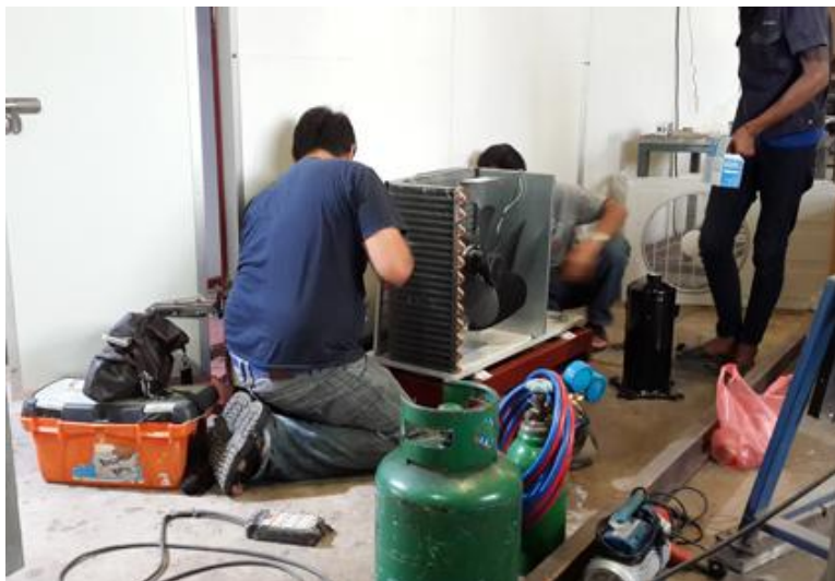
รูปที่ 12 ติดตั้งอุปกรณ์วัดอุณหภูมิ หลังคอยล์เย็น
