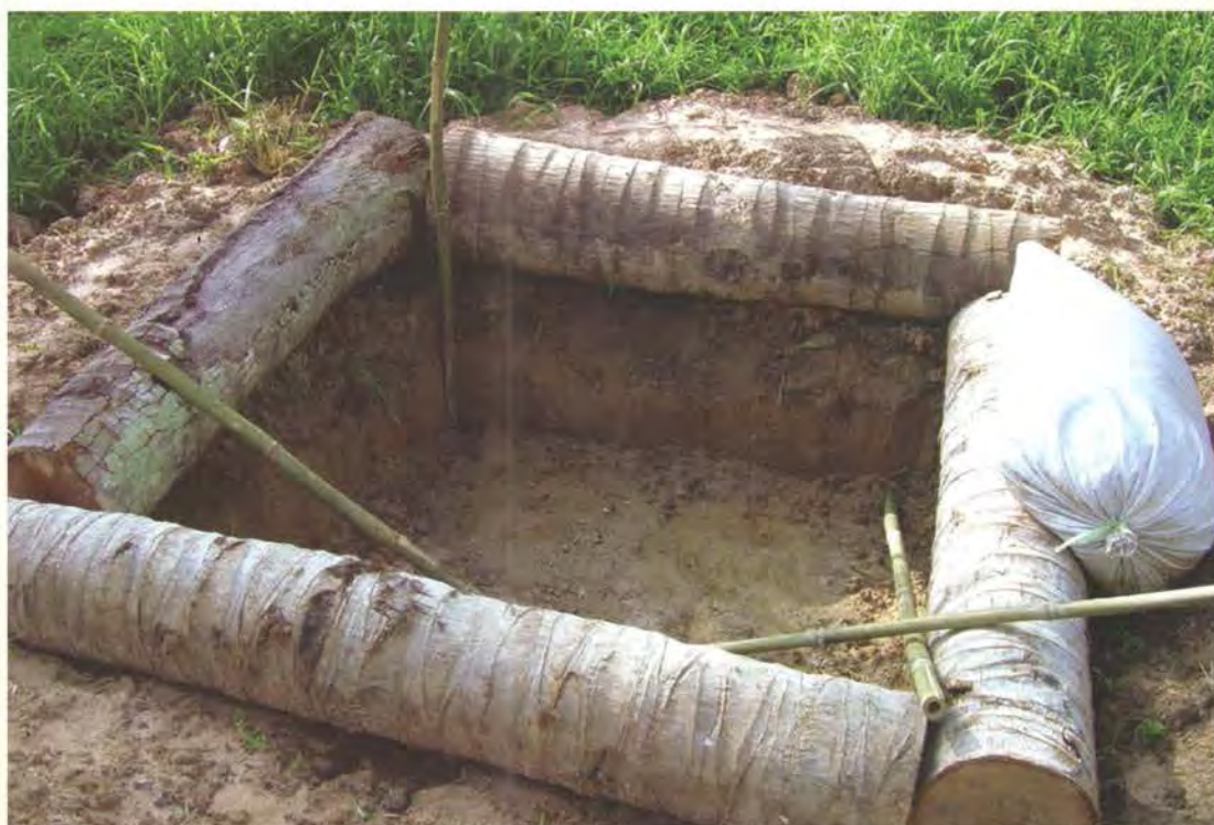
ขุดดินภายในกรอบให้ลึกประมาณ 30 เซนติเมตร
