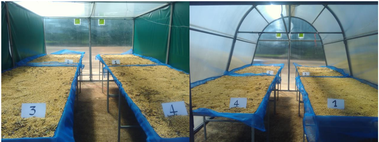
ภาพที่ 16 แสดงโครงสร้างภายในโรงตากทั้งทรงหลังคาหน้าจั่ว และทรงหลังคาโค้ง ที่ดำเนินการประกอบเรียบร้อยแล้ว พร้อมทั้งจัดตั้งชั้นตากถั่วเหลืองภายในโรงตาก สำหรับใช้เปรียบเทียบกับกรรมวิธีของเกษตรกร ซึ่งทำการติดตั้งเรียบร้อยแล้วที่สถานีแปลงทดลองของศูนย์วิจัยพืชไร่เชียงใหม่ (พร้าว) อ.พร้าว จ.เชียงใหม่ เพื่อเตรียมทดลองในช่วงเก็บเกี่ยวผลผลิตปลายฤดูฝน ปี 2560
