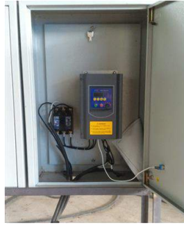
ภาพที่ 2.22 อุปกรณ์ปรับความเร็วมอเตอร์ขับ
