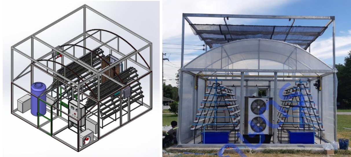
ภาพที่ 2.8 โรงเรือนกระตุ้นตาดอกดำเนินการก่อสร้างที่ ศูนย์วิจัยเกษตรวิศวกรรมเชียงใหม่
