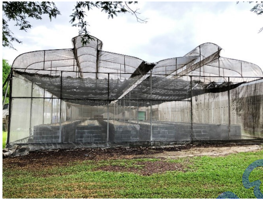
ลักษณะโครงสร้างหลังคาแบบจั่วสองชั้น
