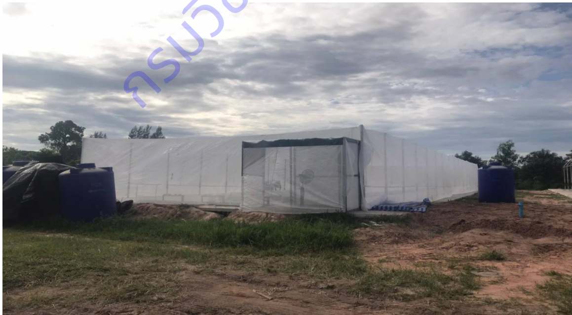
ภาพที่ 7 ลักษณะของโรงเรือนระบบเปิดใช้มุ้งคลุมทั้งโรงเรือน ขนาด 9x30 เมตร ที่ทำการสร้างเพื่อใช้ในการทดสอบที่ ศูนย์วิจัยและพัฒนาเมล็ดพันธุ์พืชขอนแก่น
