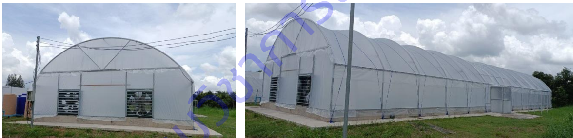
ภาพที่ 3 ลักษณะของโรงเรือน Evap (Evaporative Cooling System) ขนาด 9x30 เมตร ณ ศูนย์วิจัยและพัฒนาเมล็ดพันธุ์พืชขอนแก่น
